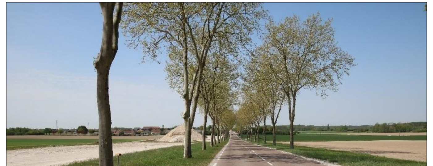
Photo 9 : Alignements d'arbres le long de la départementale D441, à l'approche Est de Vilette-sur-Aube (Source : BE Jacquel et Chatillon)
